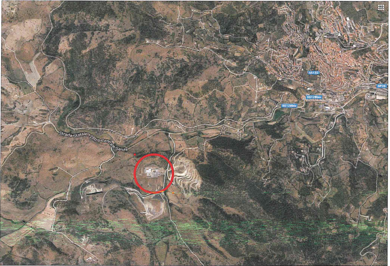
Foto 1 - Inquadramento generale dell'installazione
